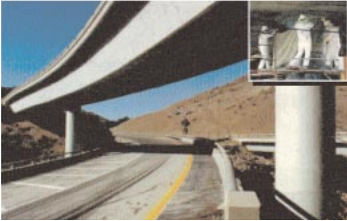
Ενίσχυση της γέφυρας Gaviota στην Καλιφόρνια των Η.Π.Α. Τα σύνθετα υλικά αφού εμποτίστηκαν με τις κατάλληλες εποξεικές ρητίνες περιτυλίχθηκαν στα υποστυλώματα ως "επίδεσμος" και αφέθηκαν να σκλήρυνθούν. Μετά τη σκλήρυνσή τους επιτεύχθηκε θεαματική αύξηση στα επίπεδα πηλασιμότητας των υποστυλωμάτων (από \mu=1 H2 πριν την ενίσχυση σε \mu=6 H8 μετά την ενίσχυση, όπου \mu ο δείκτης πηλασιμότητας μετακινήσεων).
