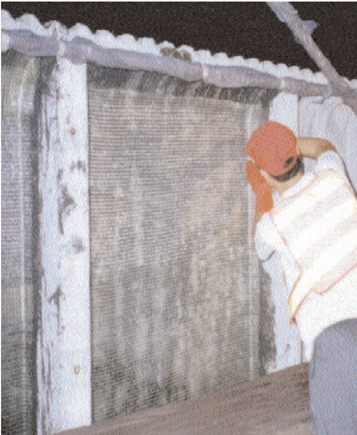
Ενίσχυση τοιχοποιίας σε κτίριο του Χονγκ-Κονγκ. Σύνθετα υλικά χρησιμοποιήθηκαν για την αύξηση της διατμητικής αντοχής της τοιχοποιίας (in-plane shear strength και out-of-plane shear strength), μετατρέποντας ουσιαστικά τη λειτουργία της σε λειτουργία τοιχίου από ο-πλισμένο σκυρόδεμα.
