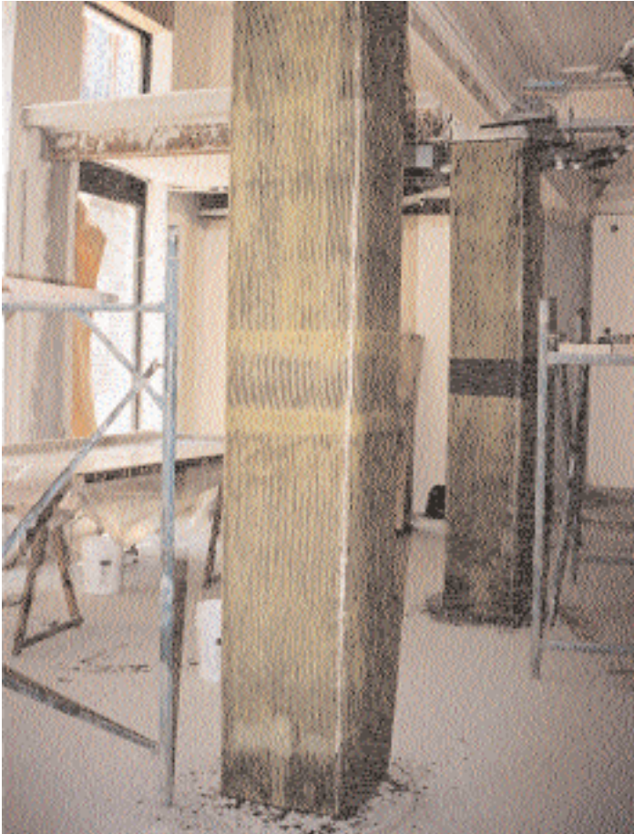
Ενίσχυση υποστυλιωμάτων κτιρίου Αγροτικής Τράπεζας Ελλάδας στη Θεσσαλονίκη. Τα σύνθετα υλικά χρησιμοποιήθηκαν λόγω του μικρού τους πάχους για την ουσιαστική αύξηση των αξονικών και καμπτικών αντοχών των υποστυλιωμάτων με μηδενική μεταβολή της δυσκαμψιάς τους, μη προκαλώντας έτσι διαφορετική κατανομή στα σεισμικά εντατικά μεγέθη των υποστυλιωμάτων από εκείνη του αρχικού σχεδιασμού του κτιρίου.
